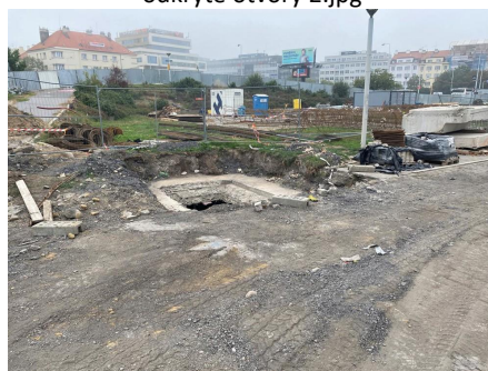
odkryté otvory 2.jpg
