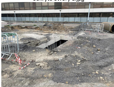
odkryté otvory 1.jpg
